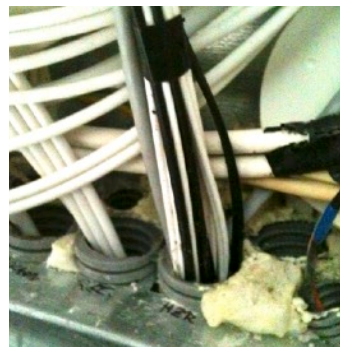
Die neun POF-Netzwerkkabel wurden durch nur 2 verfügbare Leerrohre in den Keller gezogen
