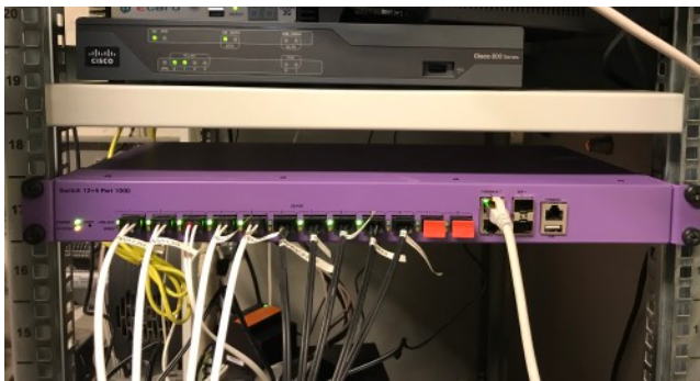
Die POF Kabel wurden schnell und einfach an den neuen Gigabit Smart Switch angeschlossen
